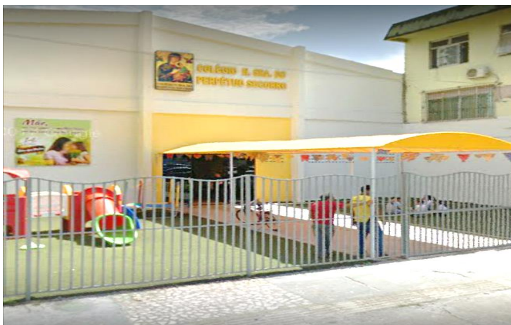
Figura 1 – Colégio Nossa Senhora do Perpétuo Socorro.
