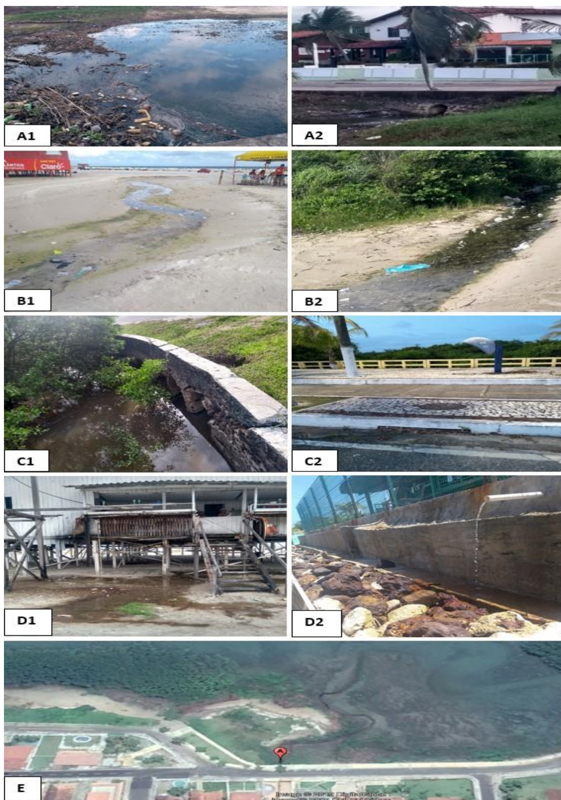
Figura 6 - (A1 e A2) Saída de esgoto doméstico para a praia do maçarico; (B1 e B2) vala a céu aberto na praia do Atalaia; (C1 e C2) bocas-de-lobo com destinação para as praias da Corvina e Maçarico; (D1 e D2) vala proveniente da lavagem de utensílios de um restaurante na praia do Atalaia e cano para escoamento da água de piscina e chuveiro na praia do Farol Velho; (E) Vista de imagem de satélite demonstrando rastro de esgoto para a praia do maçarico.
